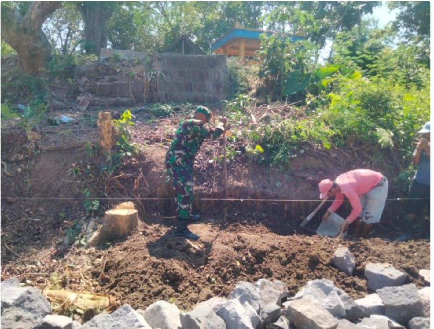
Babinsa Desa Duwet Karya Bakti Pembangunan Talud Di TPU Kyai Klungsu
